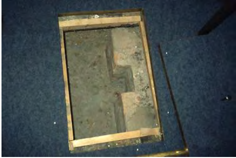
Universitäts-Sternwarte Göttingen: Der Messingbolzen im Fußboden markiert den Ausgangspunkt der Gauß'schen Landesvermessung.
