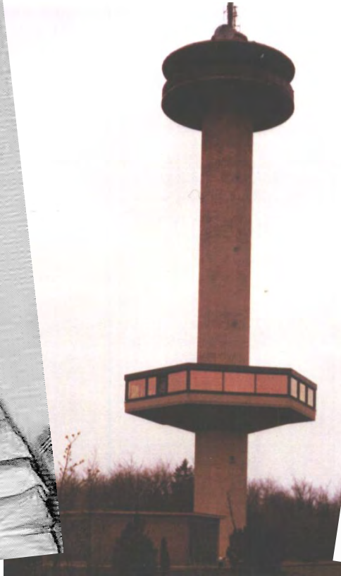
Der alte Gaußturm auf dem Hohen Hagen bei Dransfeld Grundsteinlegung: 29. 7. 1909. Einweihung: 31. 7. 1911. Infolge des Basaltabbaus eingestürzt am 14. 11. 1963
