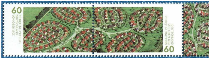
Deutschland 2021 MiNr. 3580-81 – In sieben Siedlungsteilen sind die Einzelhäuser ringförmig um einen grünen Innenbereich angeordnet.
