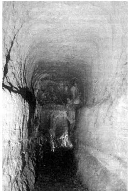
*Briord (Frankreich). Das Foto zeigt eine fehlerhaft aufgefoöhrene Vortriebsstrecke: Ein Höhenfehler wurde korrigiert, indem man den betroffenen Streckenabschnitt tieferlegte*
